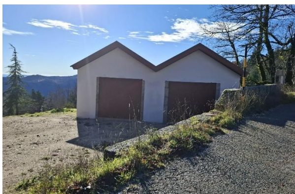
Bom estado de conservação: Anexo (Chalet da Bela Vista)
