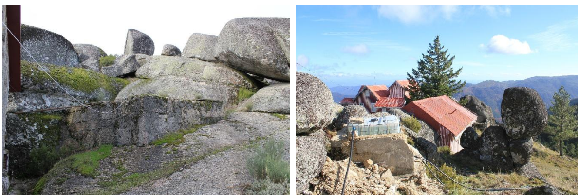
Figura 91. Tanques de armazenamento de água destinados a abastecimento das habitações
