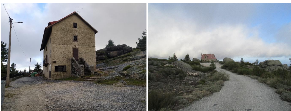
Figura 83. Estrada de ligação à Casa da Propaganda (à esquerda) e Estrada de ligação à Casa Jones (à direita)
