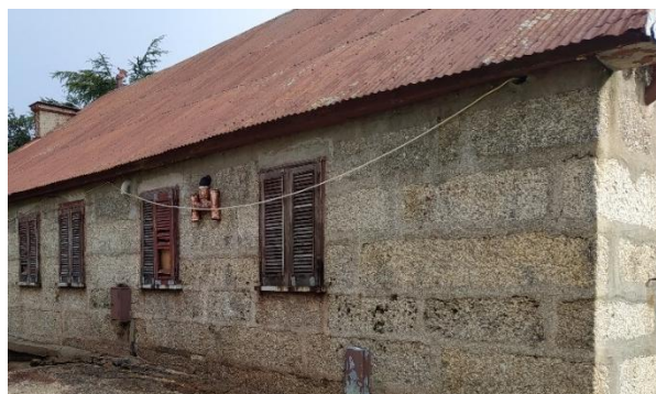
Cablagem: Casa do Rochedo
