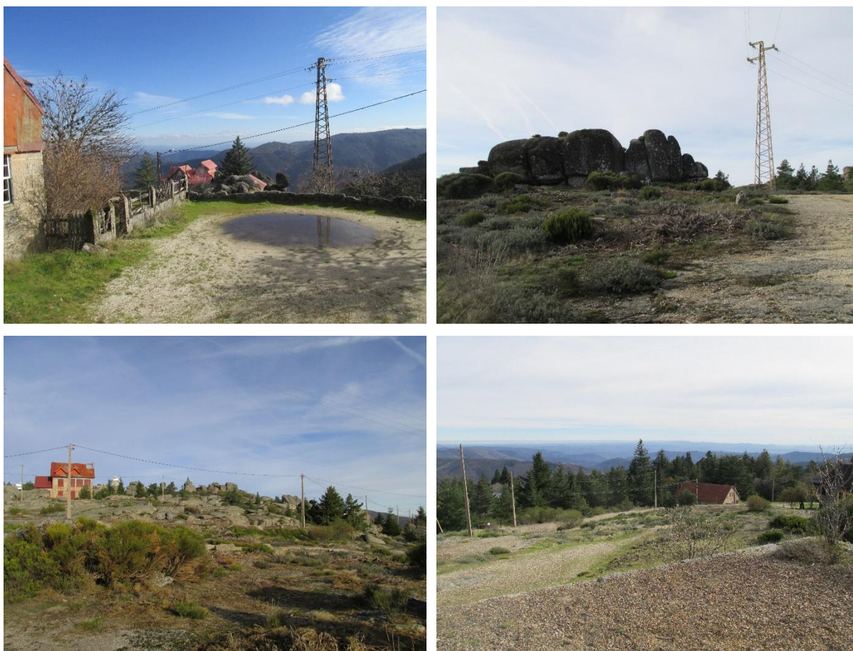
Figura 88. Linhas elétricas de alta tensão nas Penhas Douradas Em cima, postes de alta tensão junto à Casa do Guarda (à esquerda) e junto à Casa dos Parafusos Em baixo, postes de baixa tensão junto à EN 232-1
