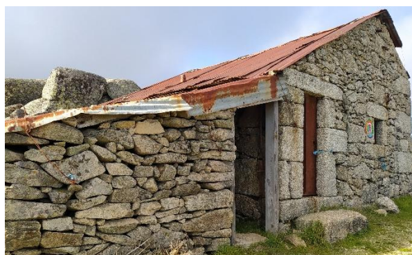
Equipamento (abrigo): Casa dos Baldios
