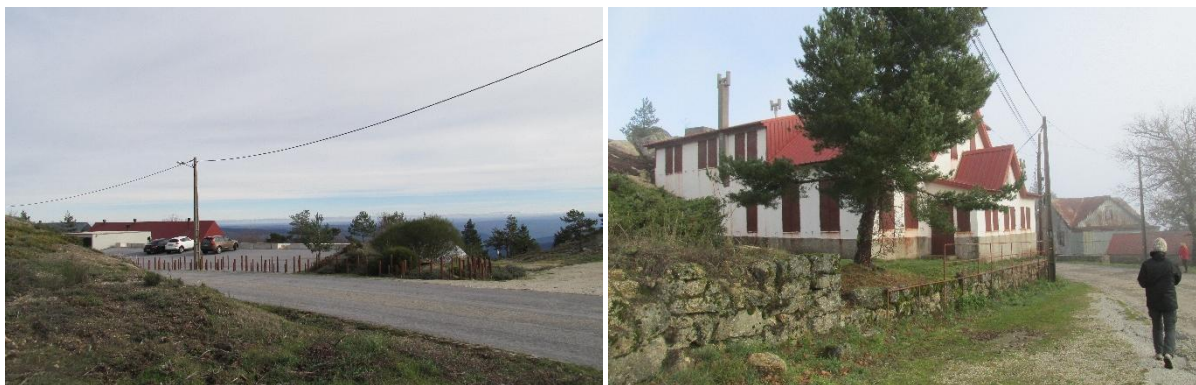
Figura 89. Postes de iluminação (à esquerda) e postes de telefone (à direita)
