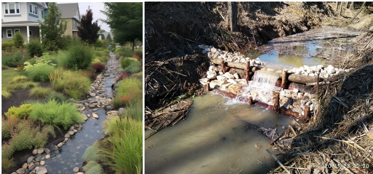
Figura 95. Exemplos de obras de engenharia natural. À esquerda, um exemplo de uma vala de drenagem renaturalizada (bioswale). À direita, um exemplo de um pequeno açude para dissipação da energia hídrica aplicado ao ribeiro de aveiras, intervenção no âmbito do projeto “Valorização e Adaptação do Ribeiro de Aveiras às Alterações Climáticas” no Município de Azambuja
