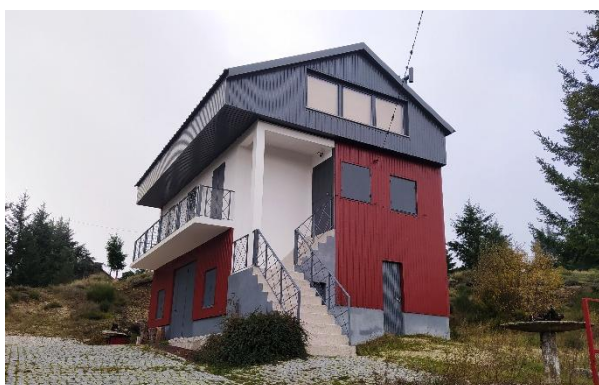
Bom estado de conservação: Casa da Fonte
