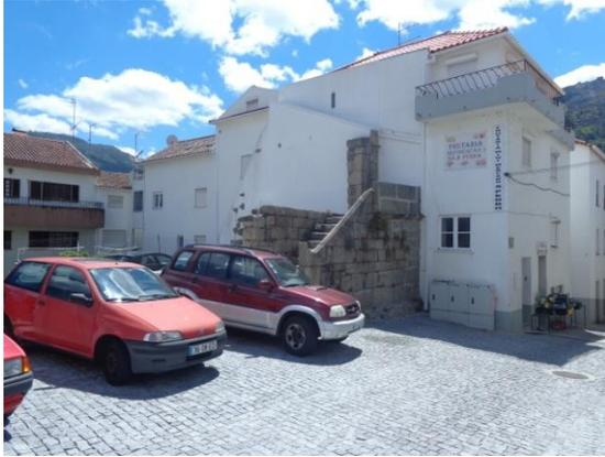
Foto 14 – Após demolição, escadaria em granito preservada.
